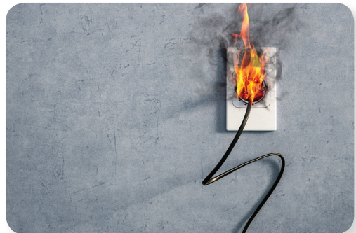
lửa do chập điện
